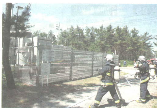
ホースを構える消防隊員。松林への延焼リスクを共有しながら放水準備を確認した(能代市河戸川の能代港変電所で)
